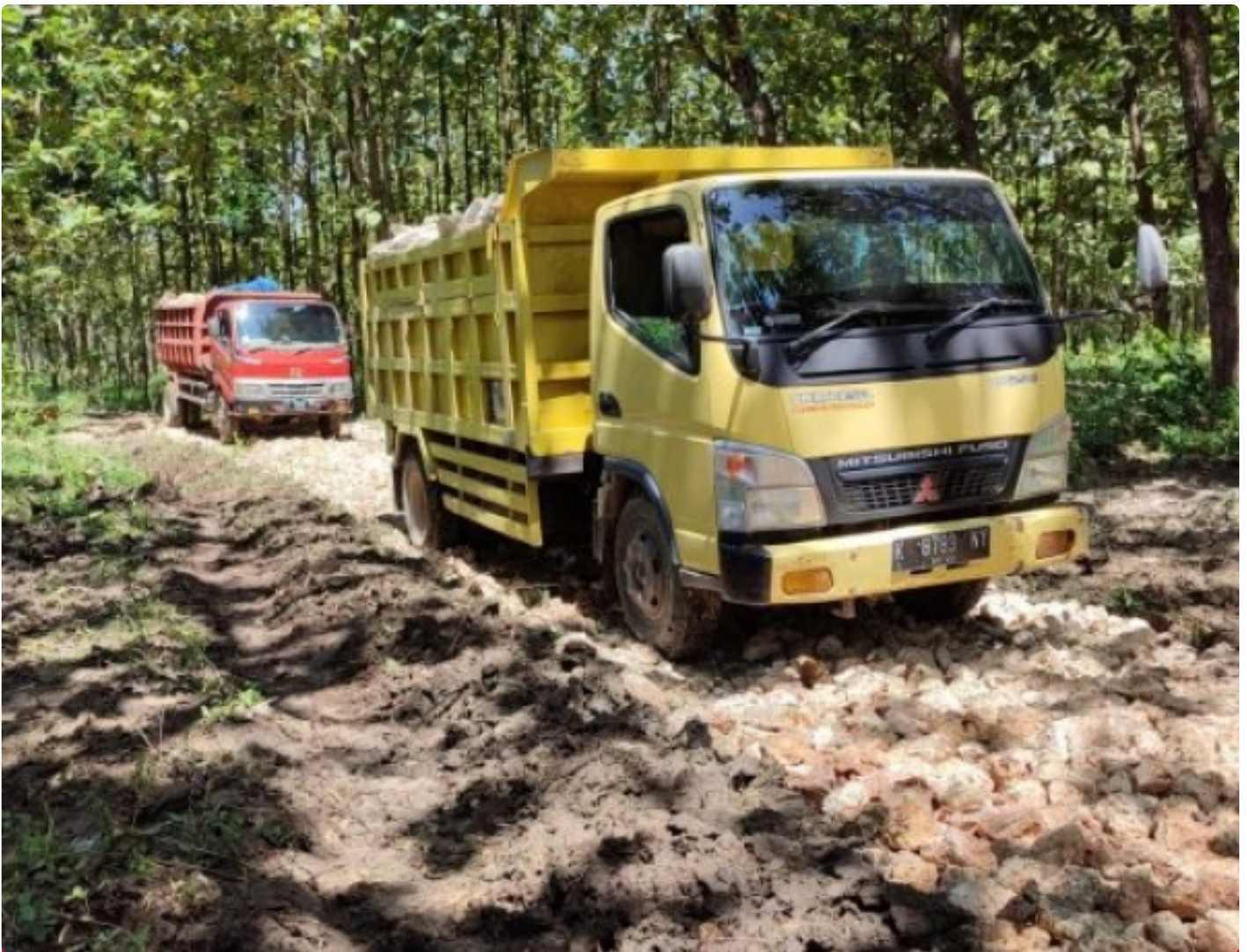
Dump truk bermuatan material tampak meliuk – lirik melewati jalan terjal arah Dukuh Alasmalang
