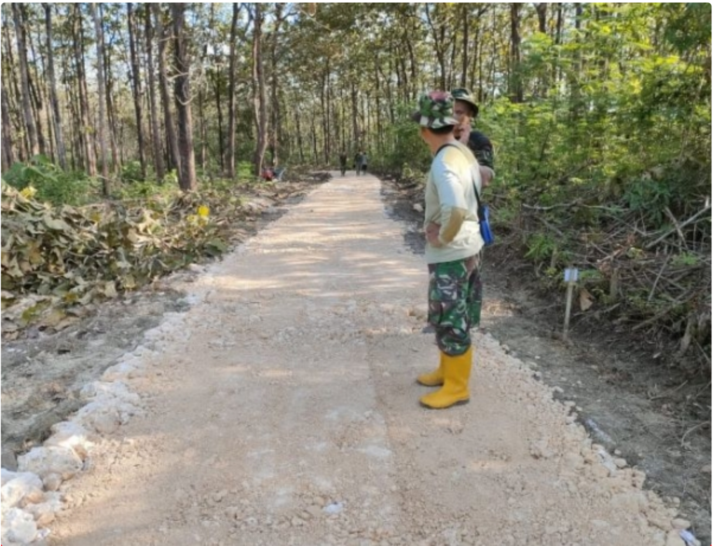
TMMD Reguler ke-113 Kodim 0721/Blora, di Desa Pengkoljagong, Kecamatan Jati, Kabupaten Blora
